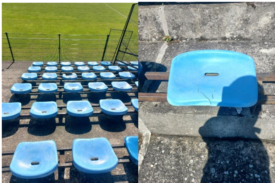
Ryc. 19. Zniszczone siedziska na widowni Stadionu Miejskiego w Kobylinie Źródło: dokumentacja zebrana podczas wizji lokalnej dnia 20.05.2025 r.
